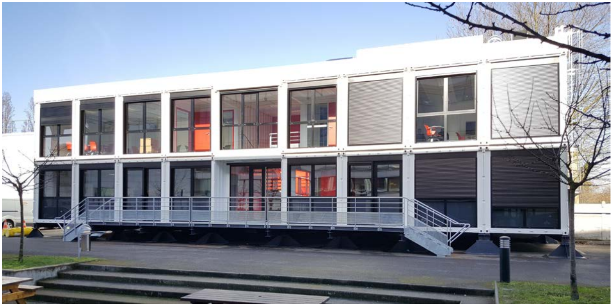
Figure 34- Bâtiment intelligent CESI Nanterre
