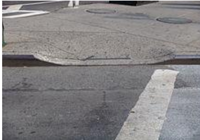
Figure 14 : exemple d'abaissement de trottoir pour piétons et cyclistes à Strasbourg (source : http://transports.blog.lemonde.fr/2012/11/07/strasbourg-sanctionne-ses-cyclistes-pour-rassurer-ses-pietons/ ).
